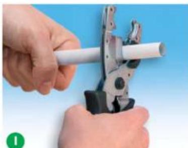
1. Отрежьте металлопластиковую трубу перпендикулярно её оси при помощи трубореза.
